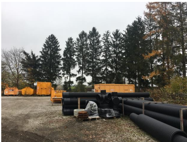
Abb. 1 BP-Fläche – Blick nach Südosten
