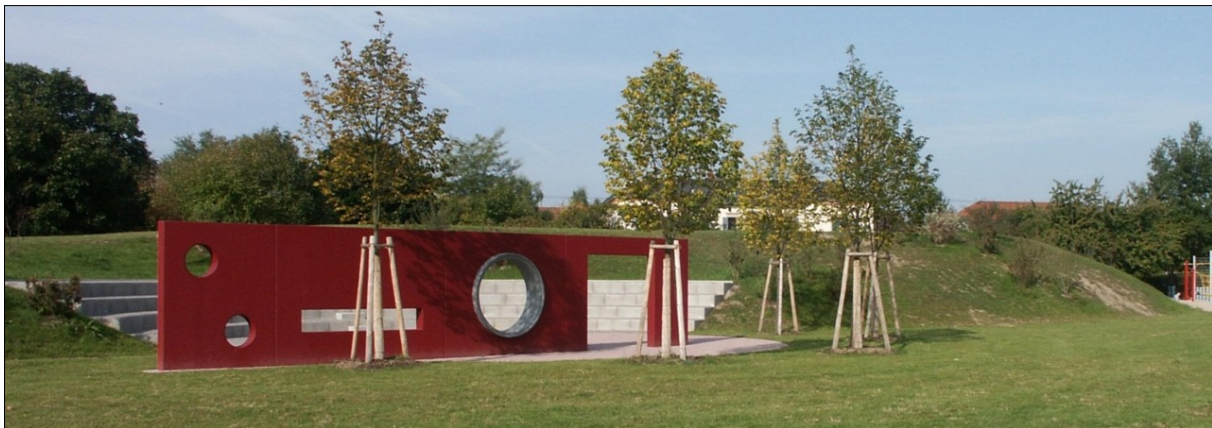
Abbildung 34: Kies-Wasser Erdbecken in Eggenstein. Bildquelle: Universität Stuttgart, Institut für Gebäudeenergetik, Thermotechnik und Energiespeicherung.
